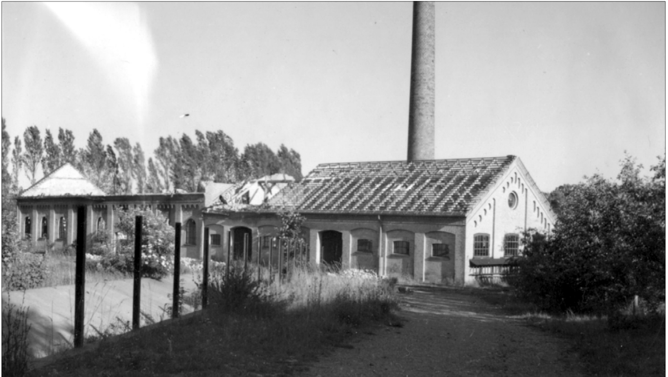
Pollerup Saftstation efter branden i 1947. Til venstre i forgrunden ses en af roerenderne; se også billedet på side 11. (Arkivfoto Svend Hansen)
